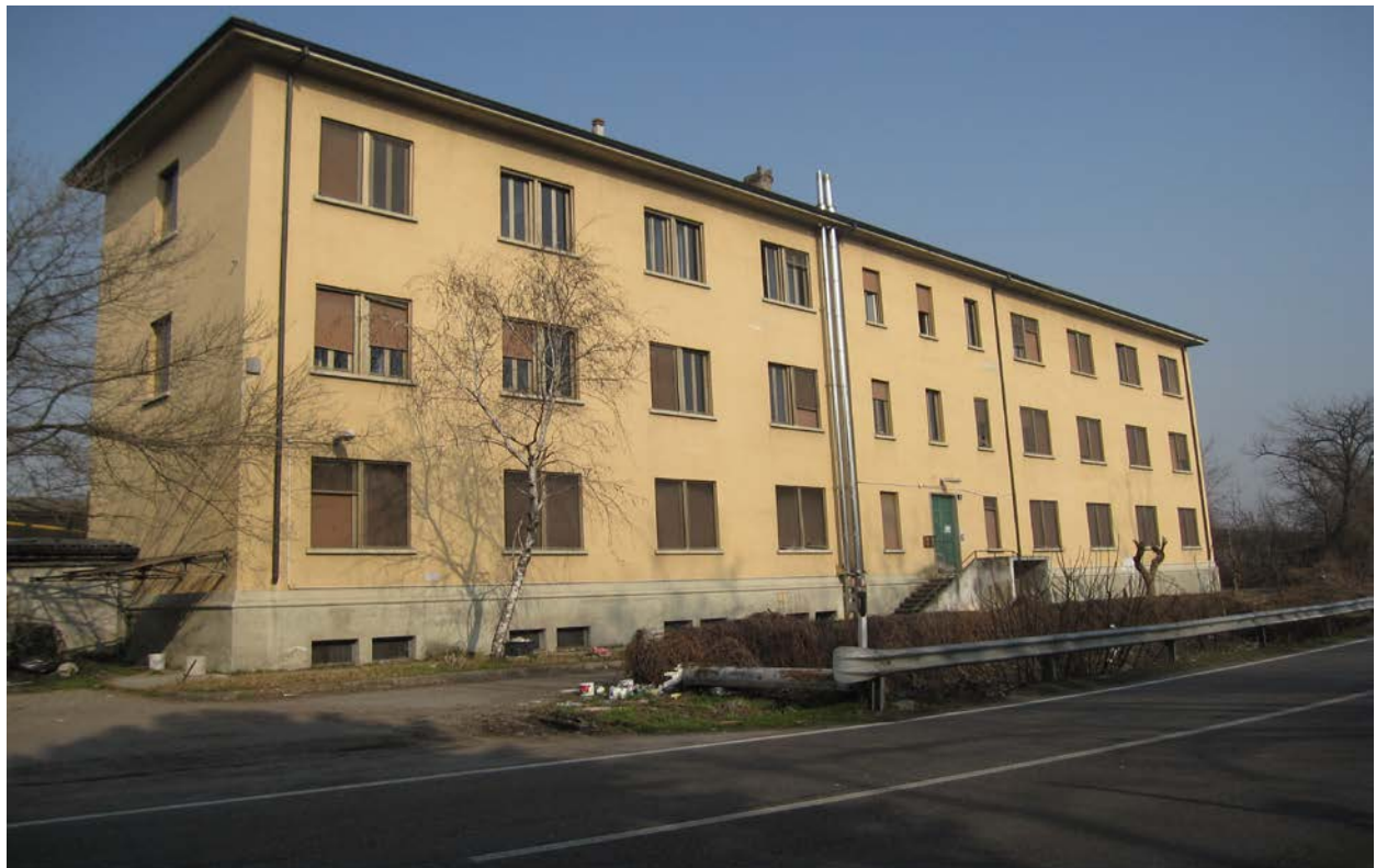
FOTO N° 4 Vista Prospetto Principale
