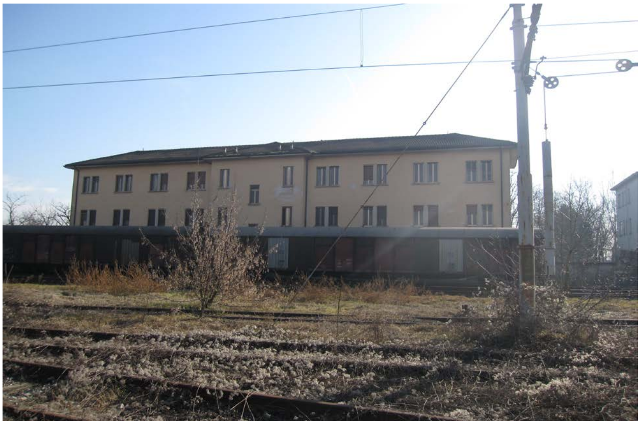
FOTO N° 6 Vista Prospetto Retro lato R.R.I.
